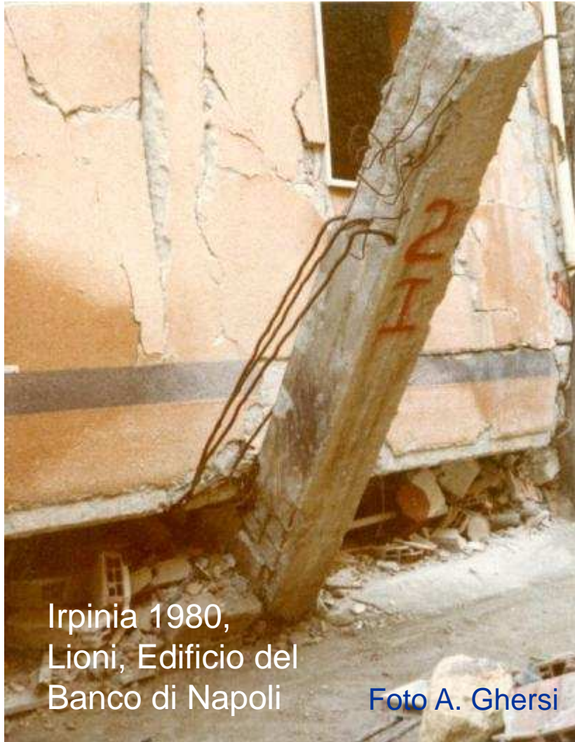
Scorrimento tra la sommità del pilastro e la trave in corrispondenza della ripresa di getto
